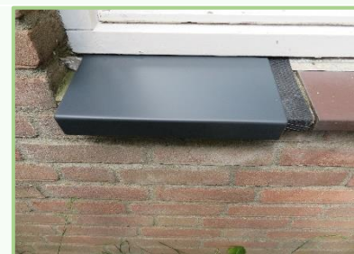
1 e Toptegel schuivend op de lijm leggen en wat aanduwen
