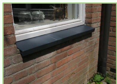
schuivend positioneren voor een gelijke verdeling
