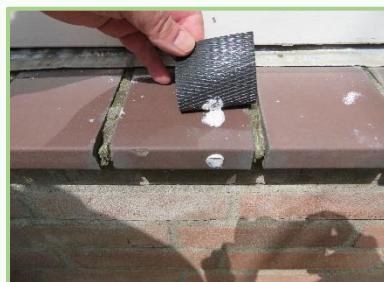
waterkeringsfolie erop plakken (meegeleverd)
