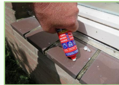
daar 3 dotjes lijm aanbrengen
