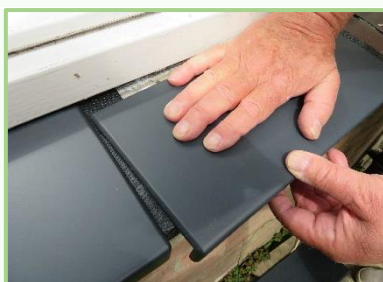
alleen onder de naden komt waterkeringsfolie
