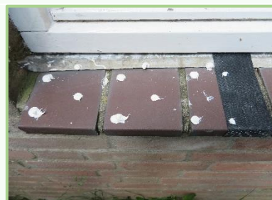
enkele dotjes lijm aanbrengen (ook op de loodstrip)
